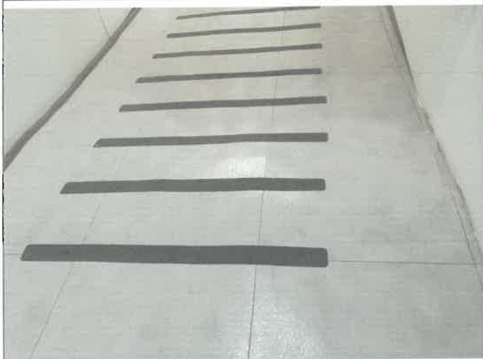
여자 락카실 입구 경사면 미끄럼방지 사포 테이프 교체시공
