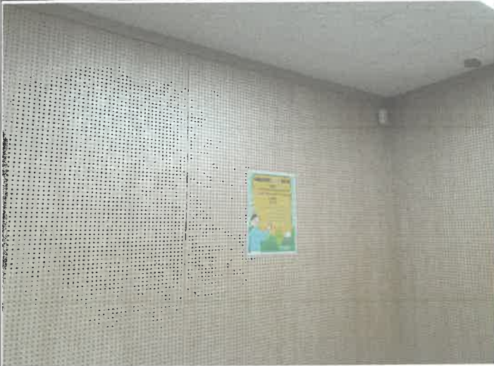
3층 드럼연습실 벽 방음판 파손개소 보수
