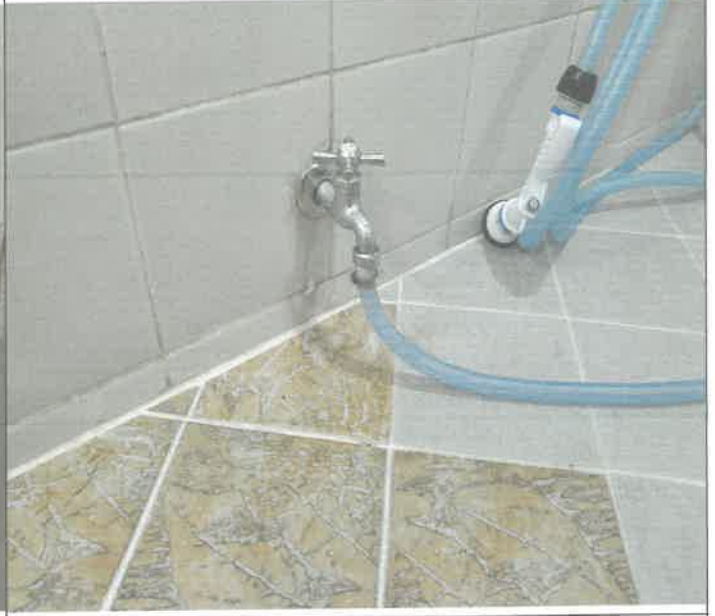
수영장 남자 샤워장 내 청소용 수도꼭지 호스 연결 밴드 교체
