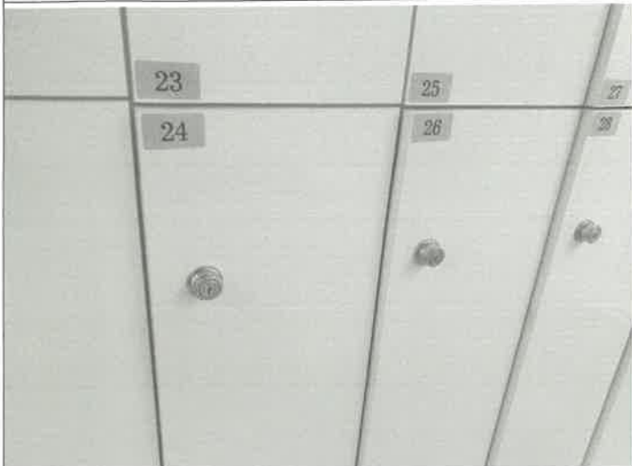
수영장 남자 탈의실 락카 키뭉치 2개소 교체 설치
