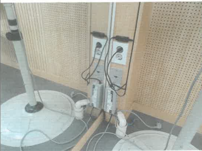
지하 아지트 이동용 난방기구 플러그 콘센트 소손 교체
