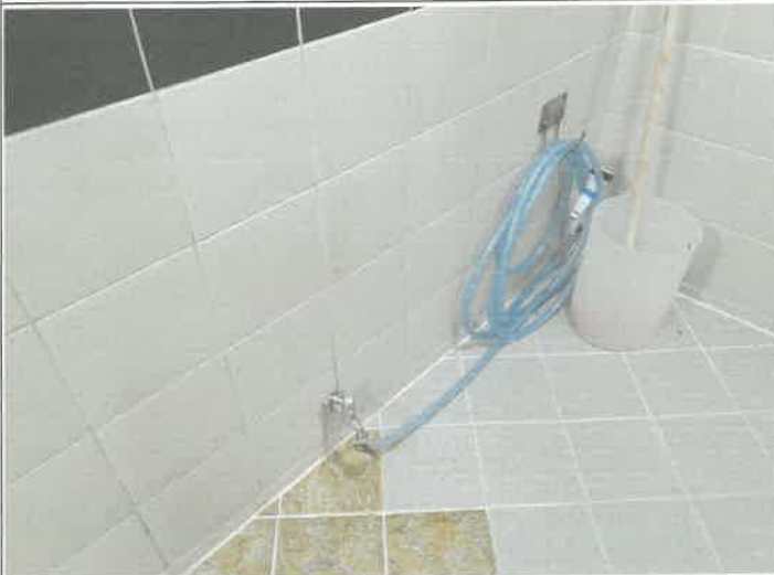
수영장 남자 샤워실 청소용 호수 노즐 점검수리
