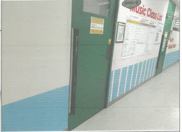
3층 피아노실 손끼임방지 파손 교체
