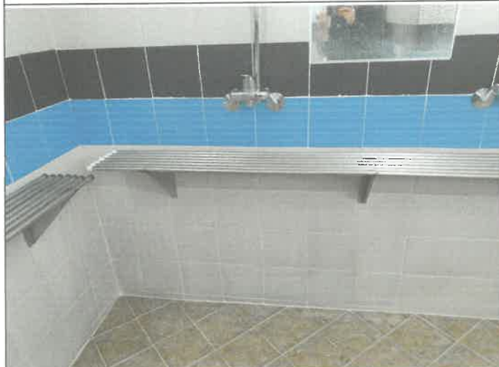
수영장 남자 샤워실 비누받침대 용접단락개소 전기 용접수리
