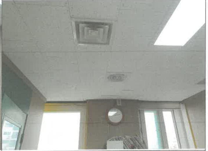
피아노실 천장 마감 몰딩 탈락 수리
