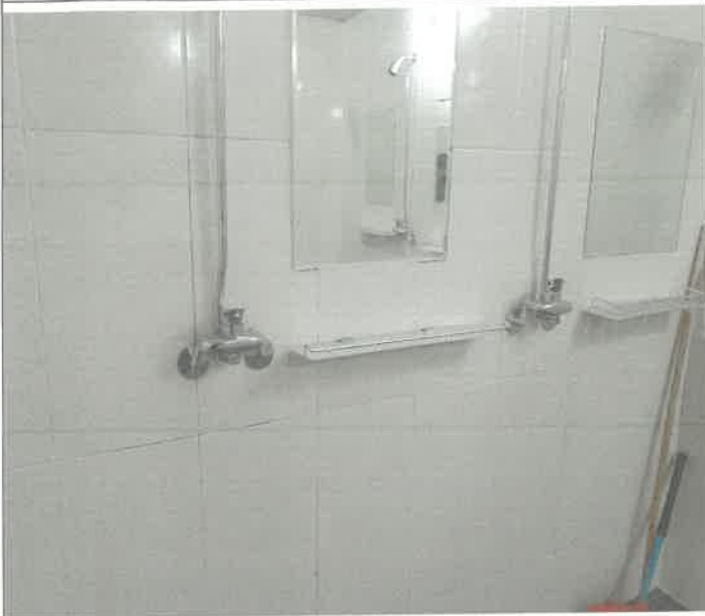
대체육관 여자 샤워장 내 샤워실 선반 탈거 되어 제설치
